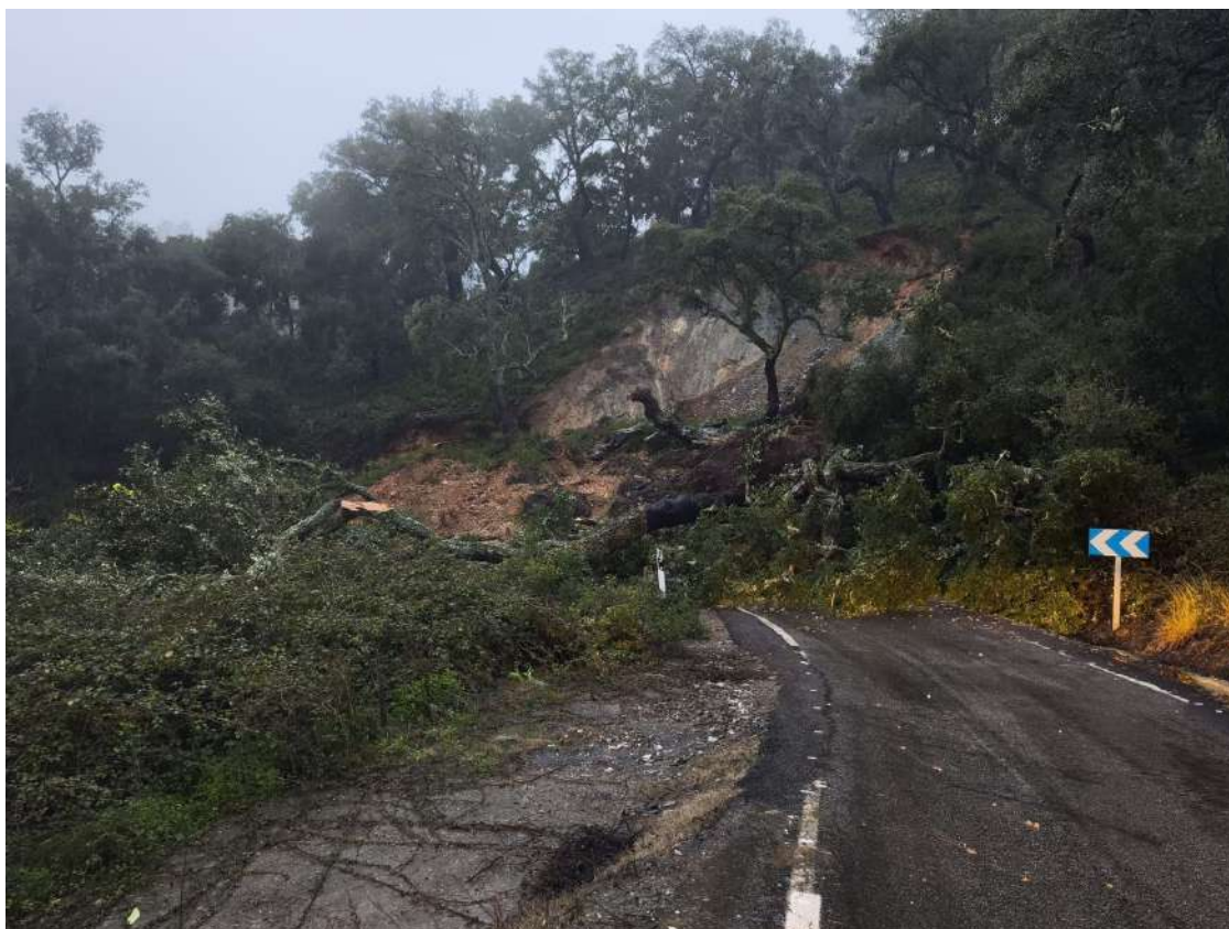
Carreteras cortadas en la provincia de Huelva.
