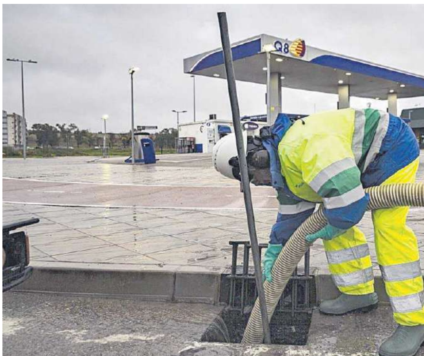
Operarios de Aqualia limpian un imbornal en la zona de El Portal, ayer.
