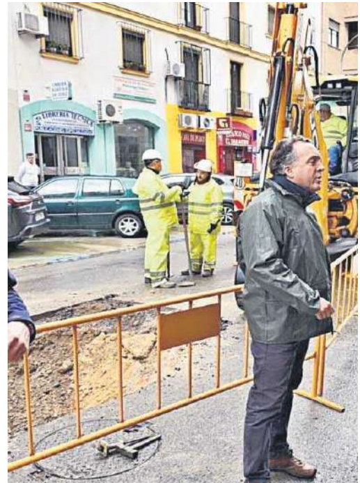
Operarios reparando la arqueta de la red de saneamiento de calle Paúl.
