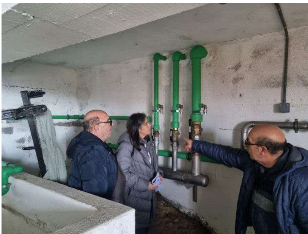
Visita a las instalaciones de suministro de agua del IES de Beade.
