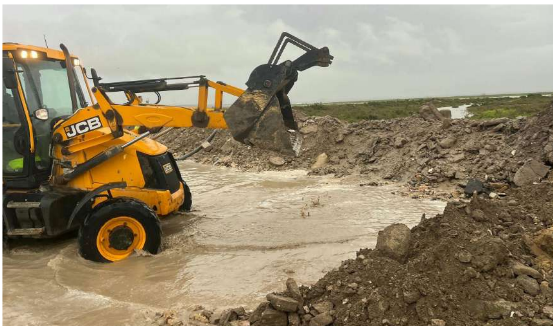
Construcción del dique en el Poblado Doña Blanca de El Puerto de Santa María para hacer frente a la crecida del río
