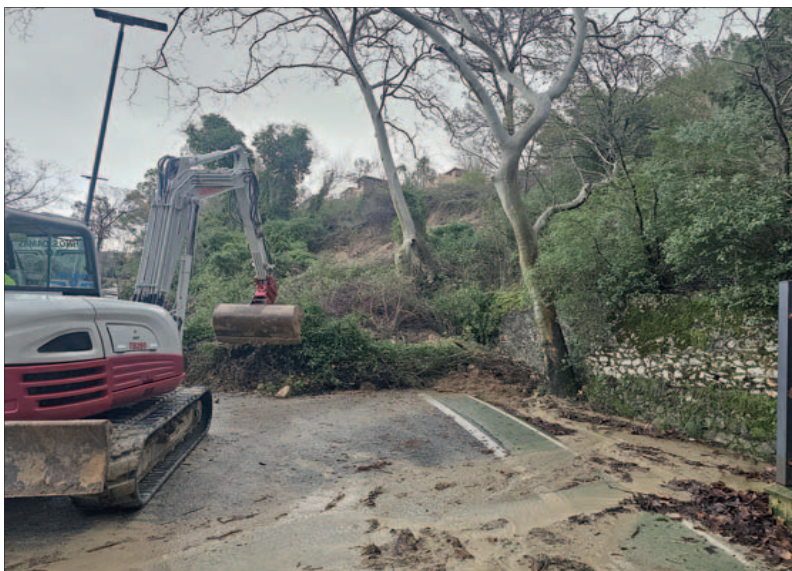
JABALCUZ. Una retroexcavadora retira los restos de broza de la carretera hacia la urbanización Buenavista.
