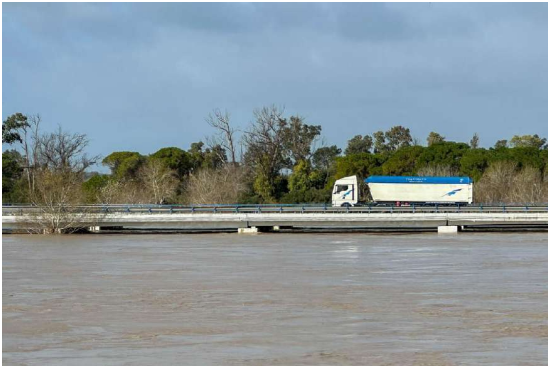
Vista de la crecida del Guadalete a su paso por la pedanía de El Portal, en Jerez de la Frontera.
