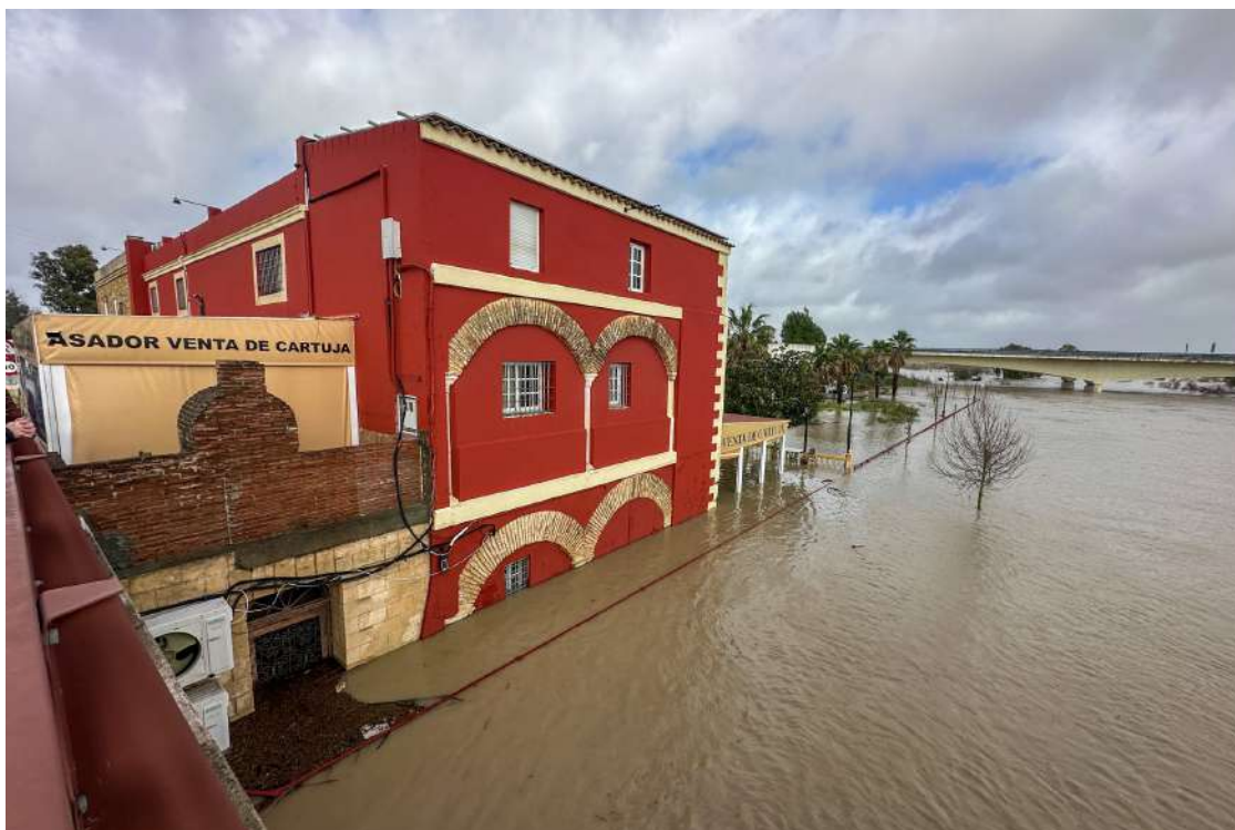
La venta jerezana que ha vivido tres inundaciones por el Guadalete en 16 años
