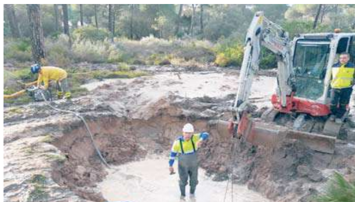
Trabajos de reparación de la tubería de abastecimiento de agua. INFOCA
