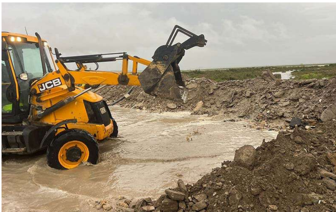
Levantando un dique de contención durante las horas más críticas / FOTO: Ayto.
