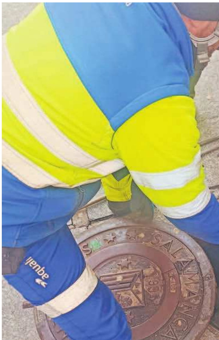
Un operario abre la tapa de una alcantarilla para comprobar que no está atascada.
