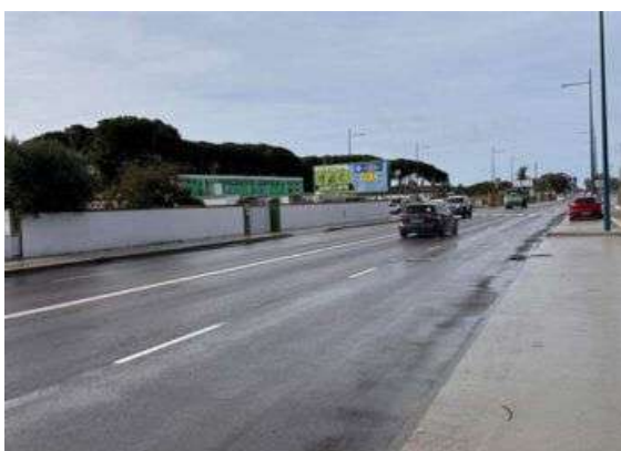
Uno de los tramos de la reurbanizada carretera / FOTO: Ayto.
