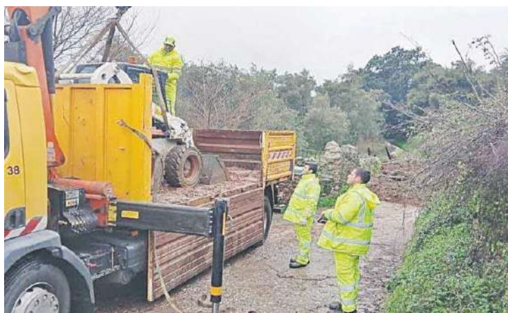
Operarios en una de las vías.
